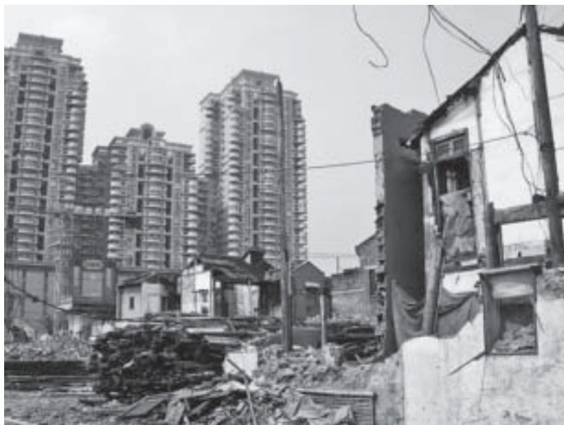
上海市區中，現代建築與正在拆除的舊式里弄並存的景觀隨處可見。
