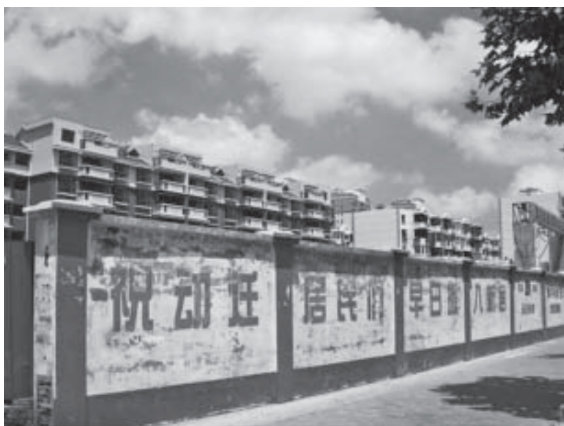
位在浦東外環線一處正在建造的拆遷戶集體安置房。
