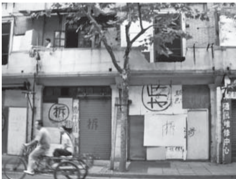
即將被拆除的房子被劃上「拆」的字樣，形成一種壓迫的空間景觀。
